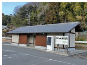
▲高山社跡の来場者用 駐車場トイレ（藤岡市）
