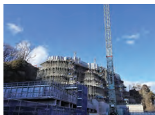
▲ 北野牧トンネルの岩山掘削現場
